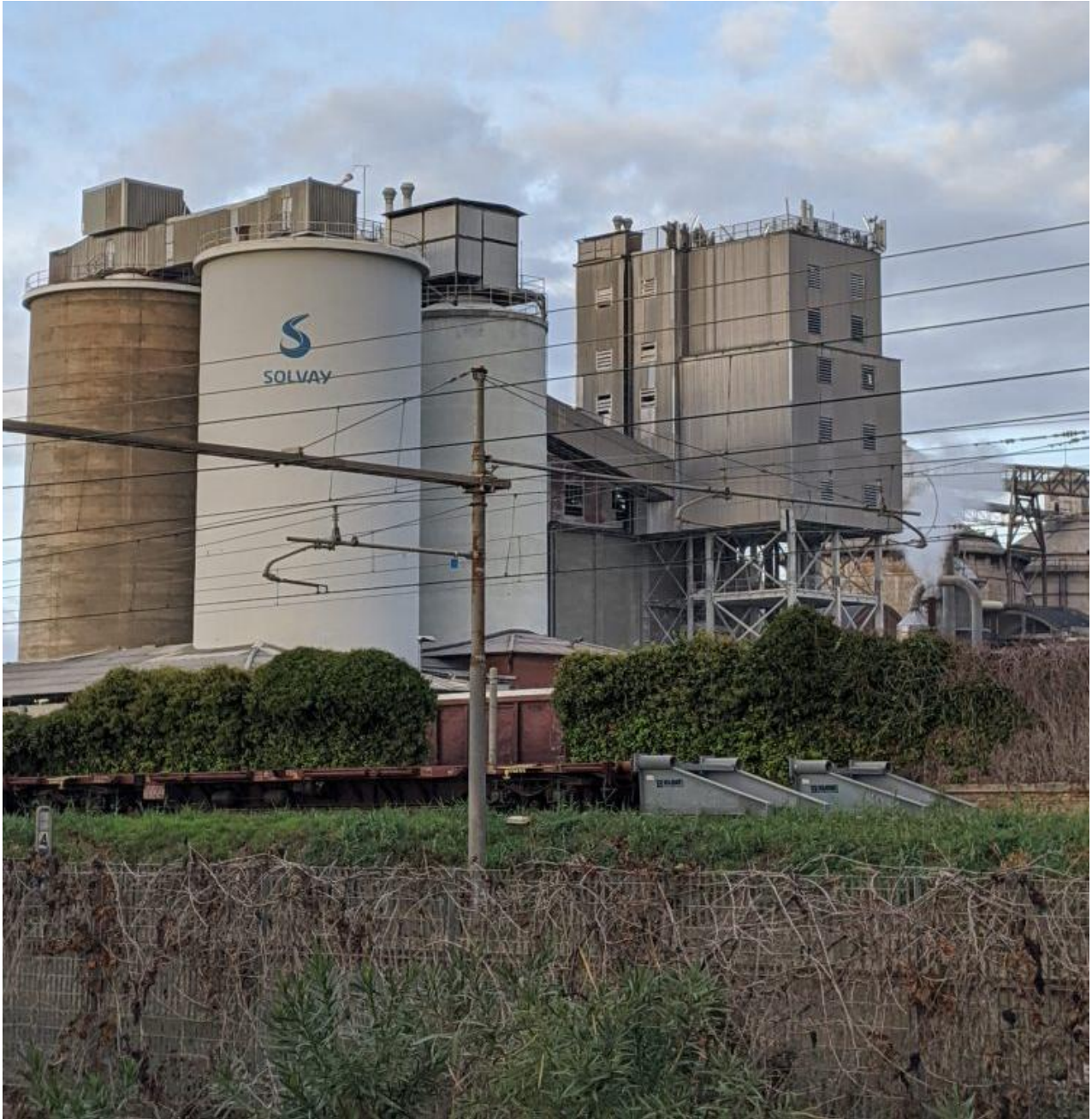
Lo stabilimento Solvay di Rosignano (DR)
